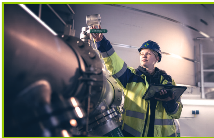
Eine Mitarbeiterin der Stadtwerke Südholstein bei der Überprüfung der Wasserversorgungsanlagen
