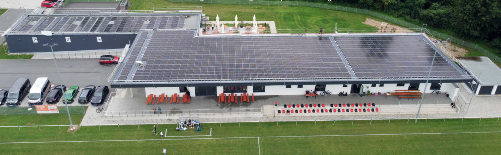
Die Photovoltaikanlage des ATSV Forchheim, Bayern mit 207,46 kWp ist ein Beispiel für das Dachpachtmodell von LIME: Der Verein verpachtet seine Dachfläche langfristig und erhält die Pacht vorab, während Planung, Bau und Betrieb der Anlage übernommen werden
